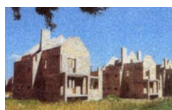
СУЧАСНЕ ЖИТЛОВЕ БУДІВНИЦТВО
